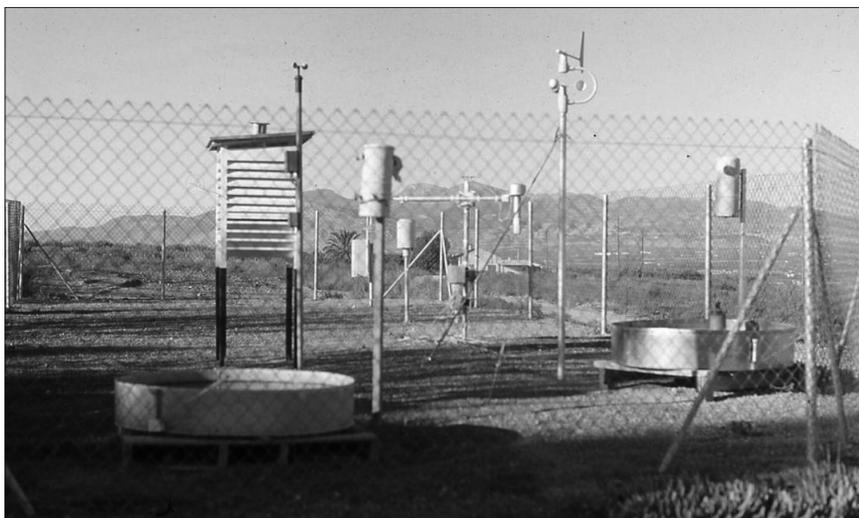
6.27 En 1979 se instaló una completa estación agroclimática que podía determinar hasta 16 variables meteorológicas, y además de permitir profundizar en el estudio de las heladas, servía de apoyo a numerosas líneas de investigación del CRIDA. (F. Bimbo. Archivo IVIA).
